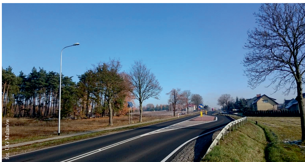
Wzdłuż drogi wojewódzkiej 470 zamontowano 3 latarnie
