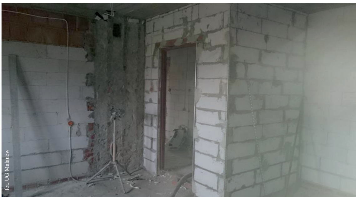
Jedno z remontowanych pomieszczeń
